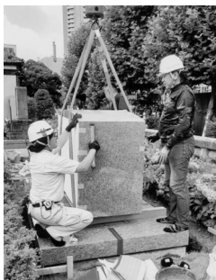
▲碑石本体を吊るし、台石に嵌め込む作業場面
