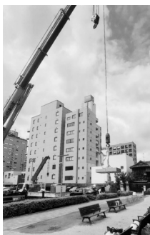
▲大型クレーンで台石を吊り上げ運んでいる場面
